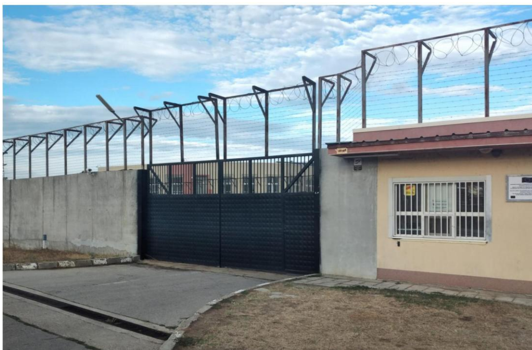
Forvaringscentret Pastrogor i landets sydlige del, hvor der bl.a. er anbragt mennesker fra Maghreb-stater under dårlige forhold.
